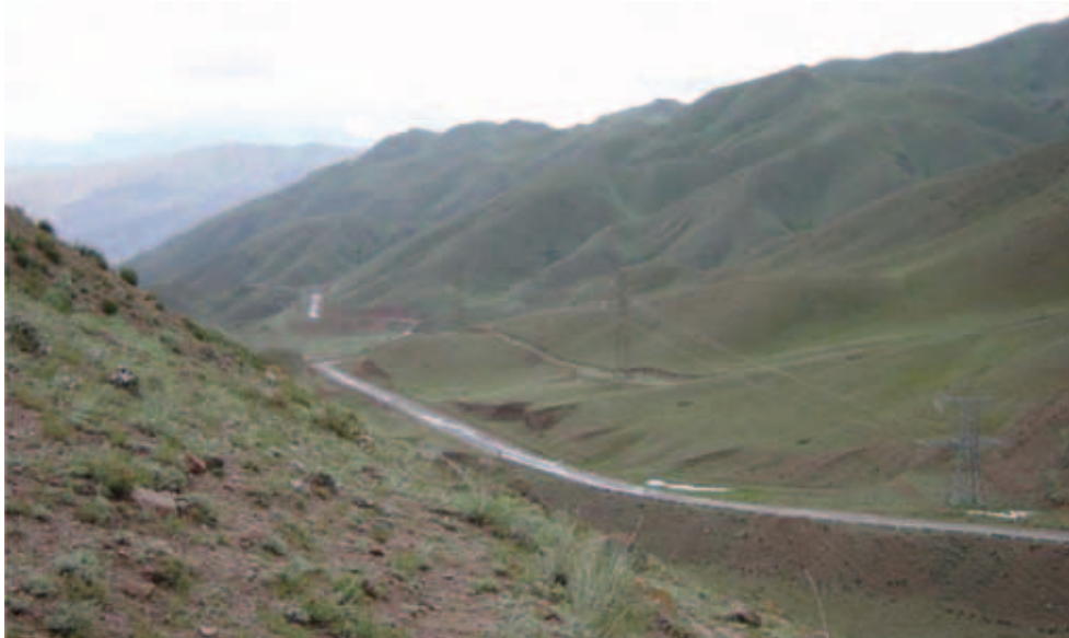
Рис. 3.9. Участок автодороги «Бишкек-Нарын-Торугарт»
