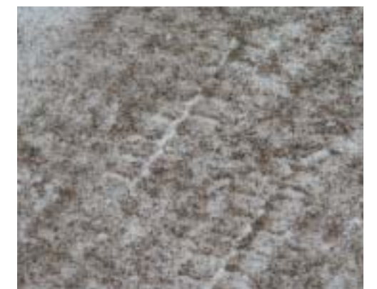
Gros plan sur la structure du revêtement
