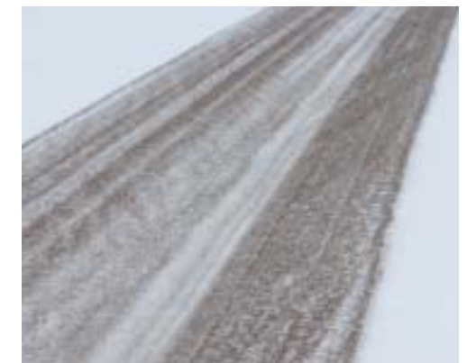
La photographie ci-dessus montre la structure de revêtement formée directement après la dispersion de sable humide
